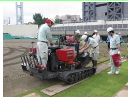
《 インストーラー施工風景 》
